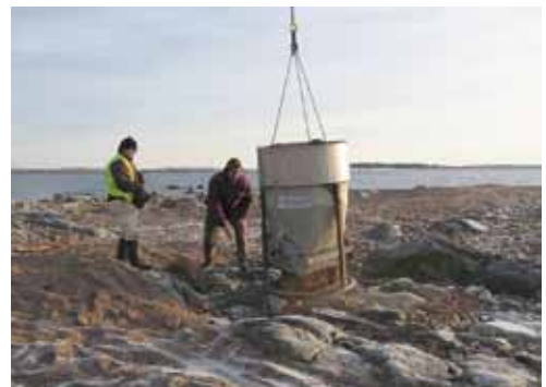
Stenarna 19 december 2007. Här styr och tömmer Ulrik Lötberg och Per Nordkvist tunnan med grus. När tunnan var tömd gällde det att snabbt fördela ut gruset med spadar och krattor innan nästa tunna anlände.
